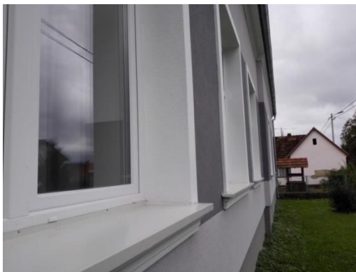
Slika 15. Izgled prozora nakon energetske obnove
