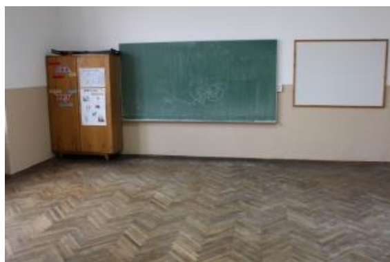
Slika 6. Unutrašnjost učionice prije radova energetske obnove
