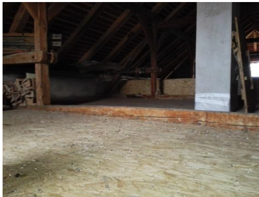
Slika 14. Izgled tavana nakon energetske obnove
