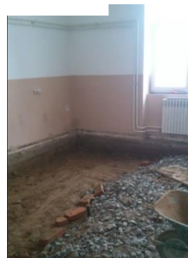
Slika 2. Pripremni radovi: uklanjanje slojeva postojećeg poda
