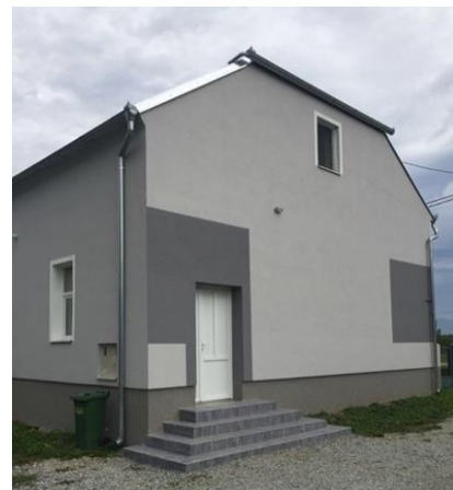
Slika 10. Južno pročelje zgrade nakon energetske obnove
