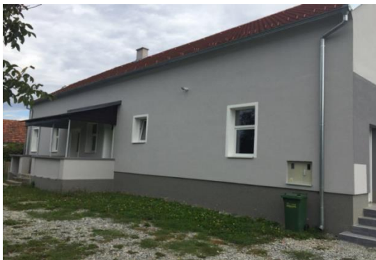
Slika 9. Zapadno pročelje zgrade nakon energetske obnove
