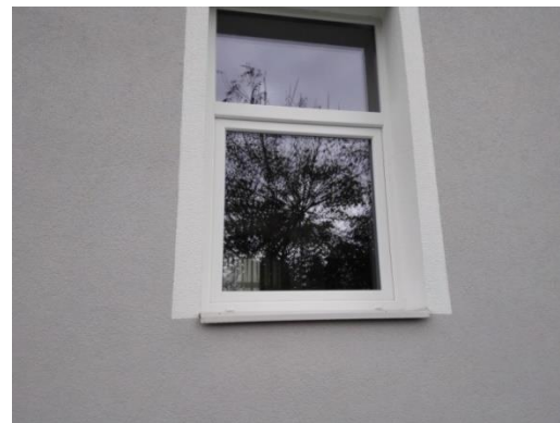
Slika 16. Izgled prozora nakon energetske obnove
